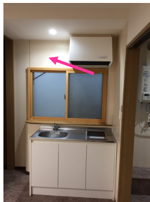
【キッチン施工後】
