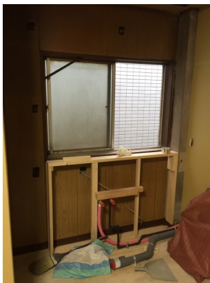
【事務所施工前】
