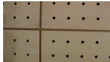
【AHIパネル(有孔タイプ)を貼り施工】
