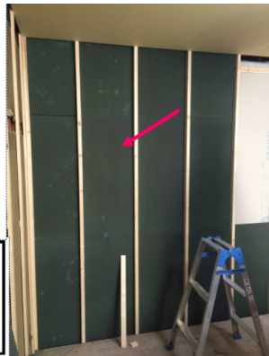
【壁面現場施工事例】
